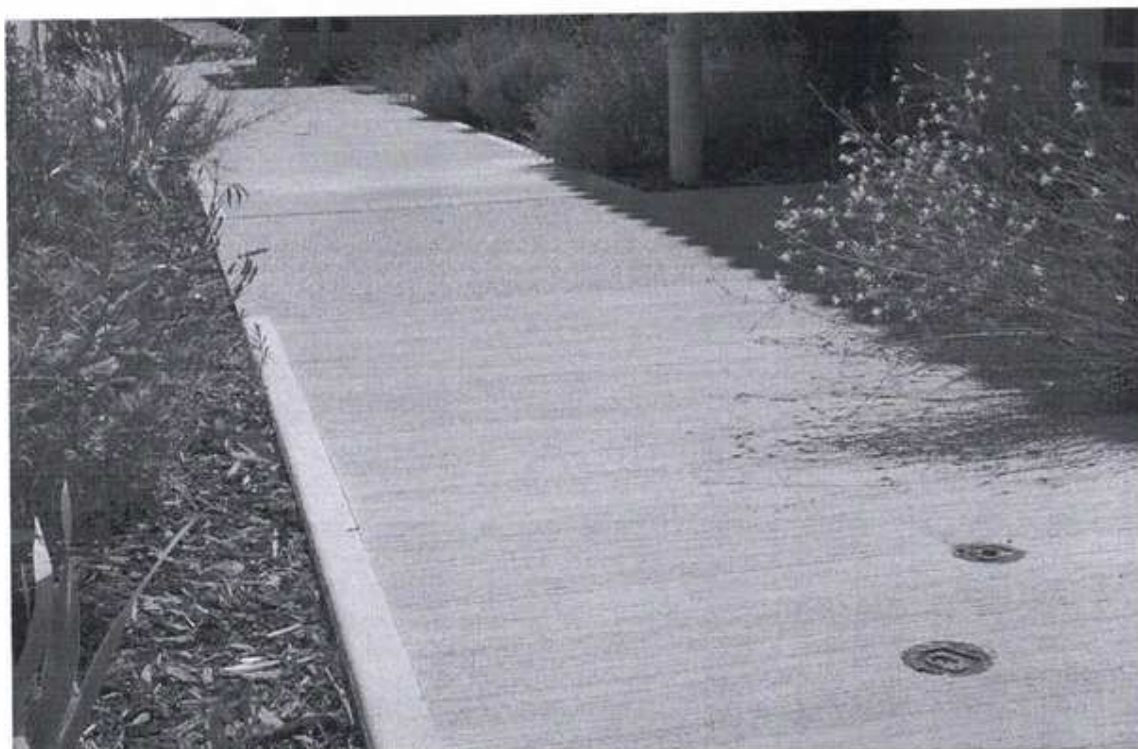
Veredas de hormigón raspinado
